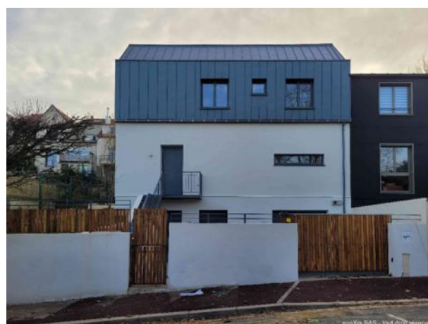
Residential building — Clamart Bâtiment résidentiel — Clamart
