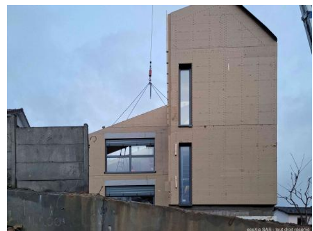
Clean and fast on-site duties Chantier rapide et propre
